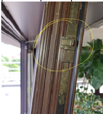
(foto 1) maniglia con "manovra logica" dotata di chiave di sicurezza
